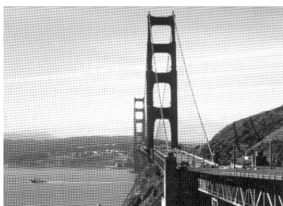
モアレが発生した例
